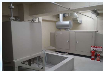
災害対策用に大型発電機を導入した例
