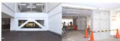
ピロティ柱鉄骨ブレース補強・袖壁による補強
