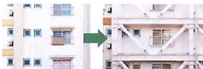
外付け鉄骨ブレースのアウトフレーム補強
