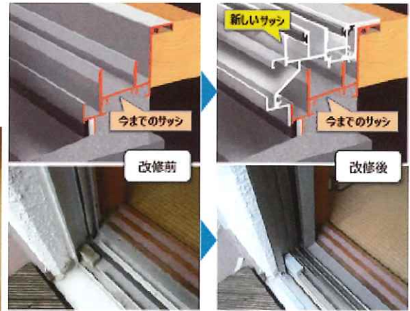
写真2 カバー工法 施工前と施工後
