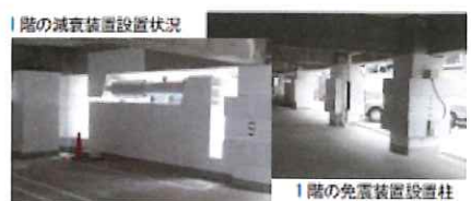
階の免震装置設置柱
