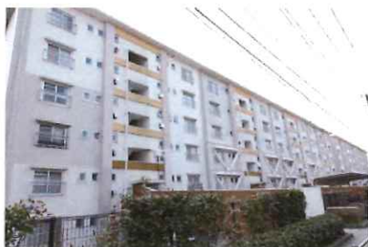
外付け鉄骨ブレースのアウトフレーム補強
