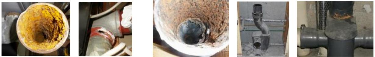
③排水用炭素鋼管の腐食 (配管・通気管)
